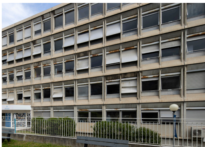
Façade du bâtiment principal - AVANT
