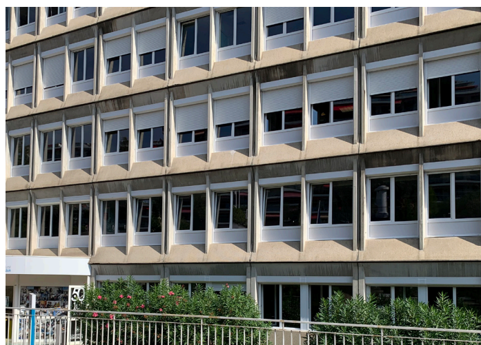
Façade du bâtiment principal - APRÈS
